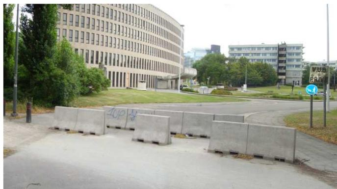
Figure 71: Dispositif bloc béton en forme de "T" inversé pour la sécurisation des piétons. Accès 10, VUB.
