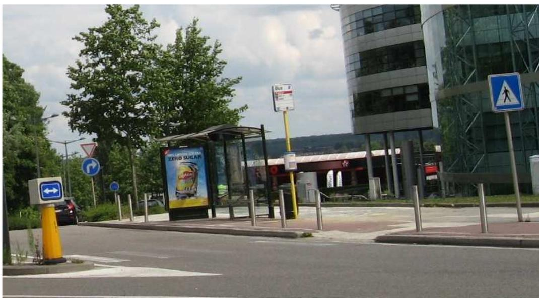
**Figure 126: Traversée piétonne du bypass côté sud du carrefour avenue Fraiteur/boulevard de la Plaine/boulevard du Triomphe : non protégée par des feux, trop larges et sans dispositif de ralentissement**
